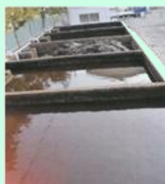
逆洗排水 (90t/d: SS20～100mg/L)
